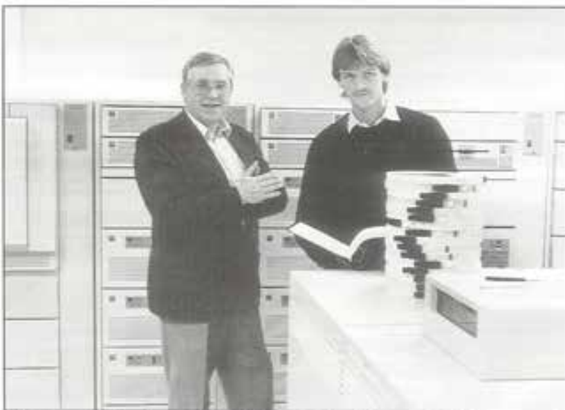
Företagets "hjärna", AS400, behöver 16 band för veckoback-uppen. En extrakopia förvaras på annat ställe. Boris Finnäs, datachef, och Anders Garin, kontrollerar att allt fungerar i den brandsäkra datahallen.
